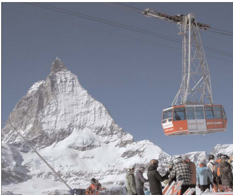
Seit kurzem schmiert der automatische Schmierstoff-Spender der simatec ag die Tragseile und Tragseil-Rollen an Seil- und Bergbahnen. Auch die Zermatter-Bergbahnen vertrauen dem Fett- und Ölspender simalube Fotos: simatec
